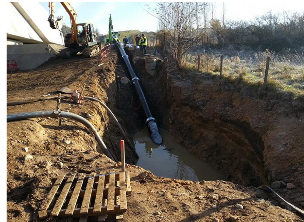
Photo 8 : Exemple de point de départ avec canalisation engagée
