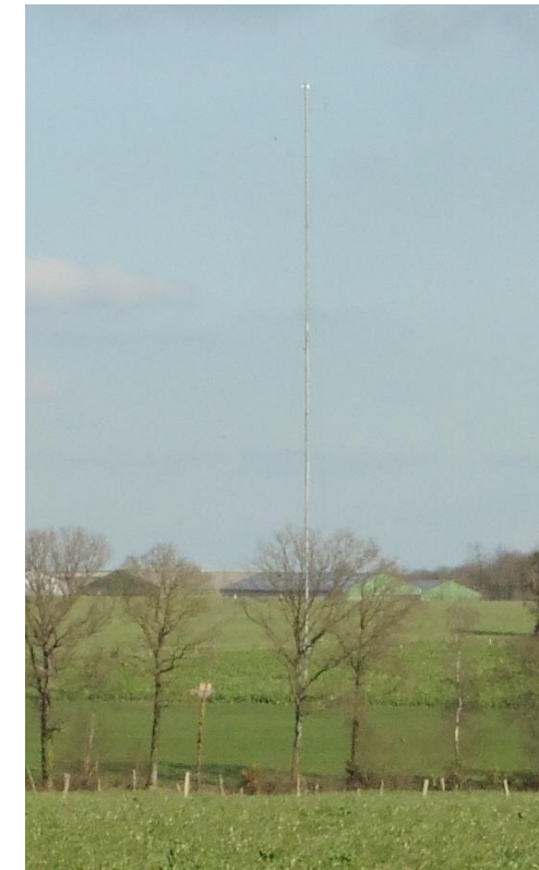
Photo 15 - Mât de mesure du vent (ferme du Chef du Bos en arrière plan)
