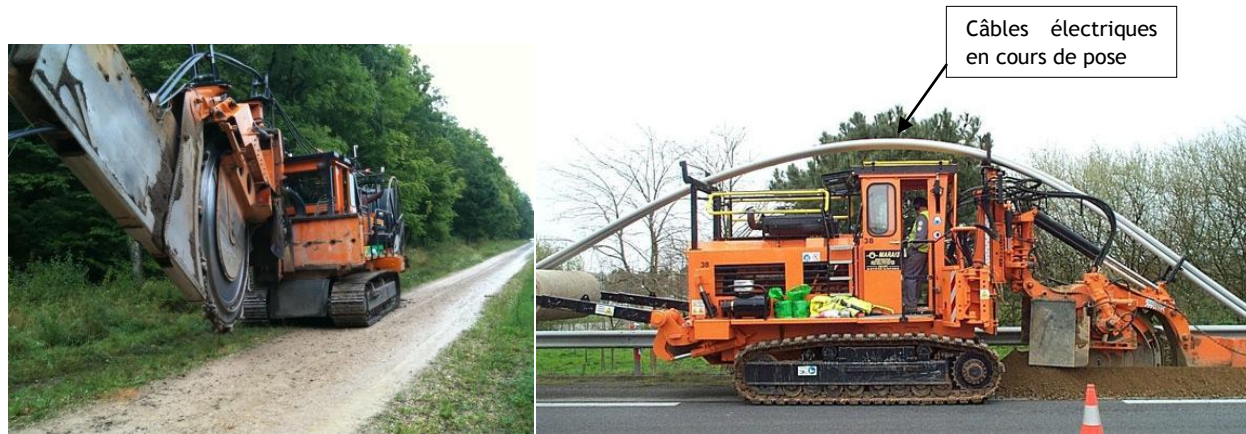
Photo 6 et Photo 7 : Trancheuse à l'arrêt et en action
