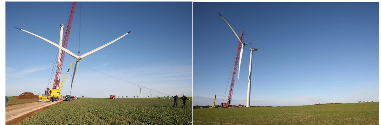
Photo 13 - Chantier de construction : montage d'une éolienne
