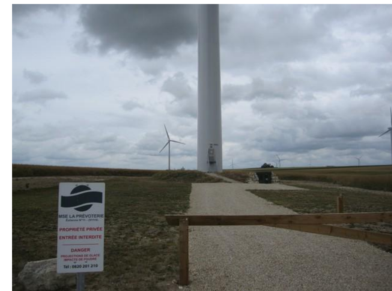
Photo 14 - Chantier de construction : remise en état du site
