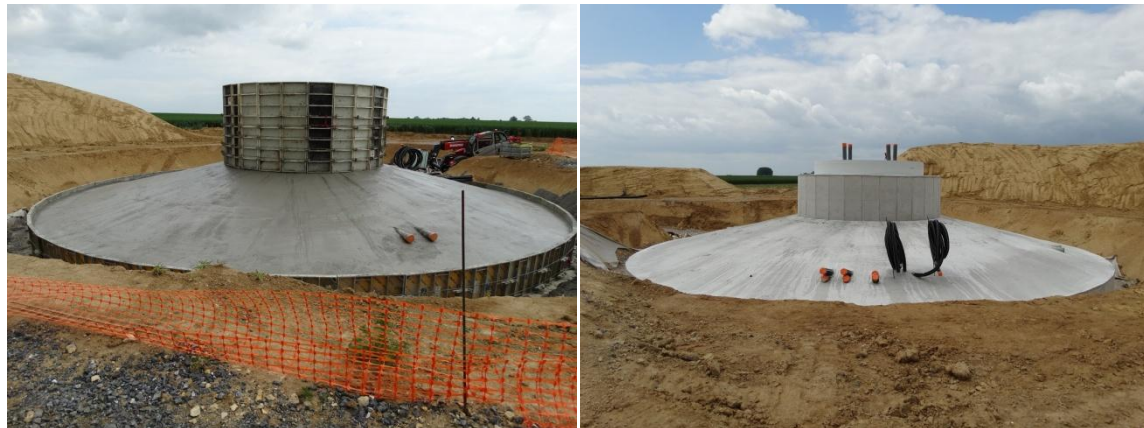
Photo 11 - Chantier de construction : réalisation d'une fondation
