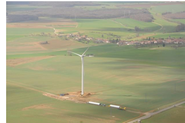
Photo 12 - Arrivée des éléments d'une éolienne sur le site
