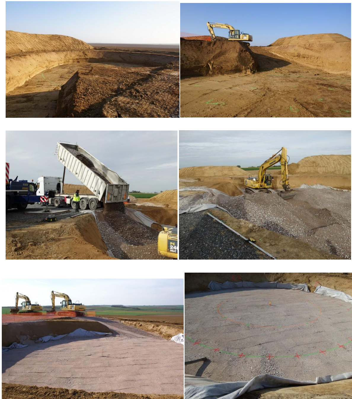
Photo 10 - chantier de construction : le terrassement des massifs
